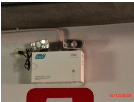
ภาพที่ 2.2-25 ไฟส่องสว่างฉุกเฉิน
