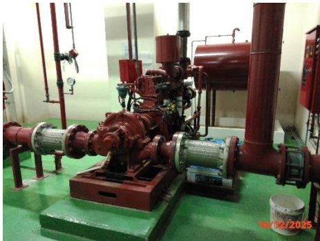
เครื่องสูบน้ำดับเพลิงชนิดเครื่องยนต์ดีเซล
